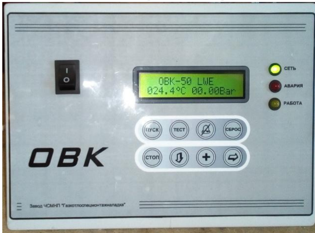
Рисунок 2 – Передняя панель блока управления котлом
